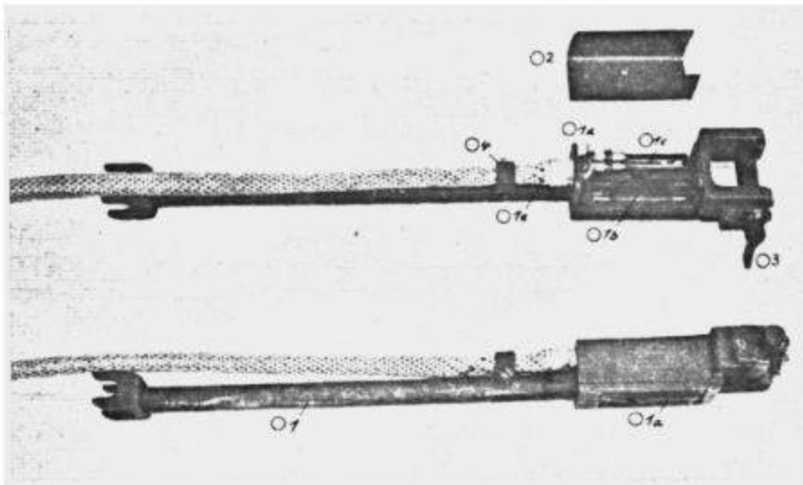
Abb. 47: Durchlade- und Zählkontaktgeber DZK 131 A
