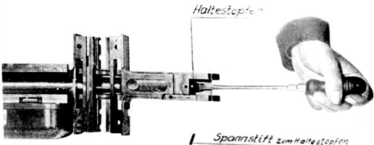
Abb. 76: Einsetzen des Haltestopfens
